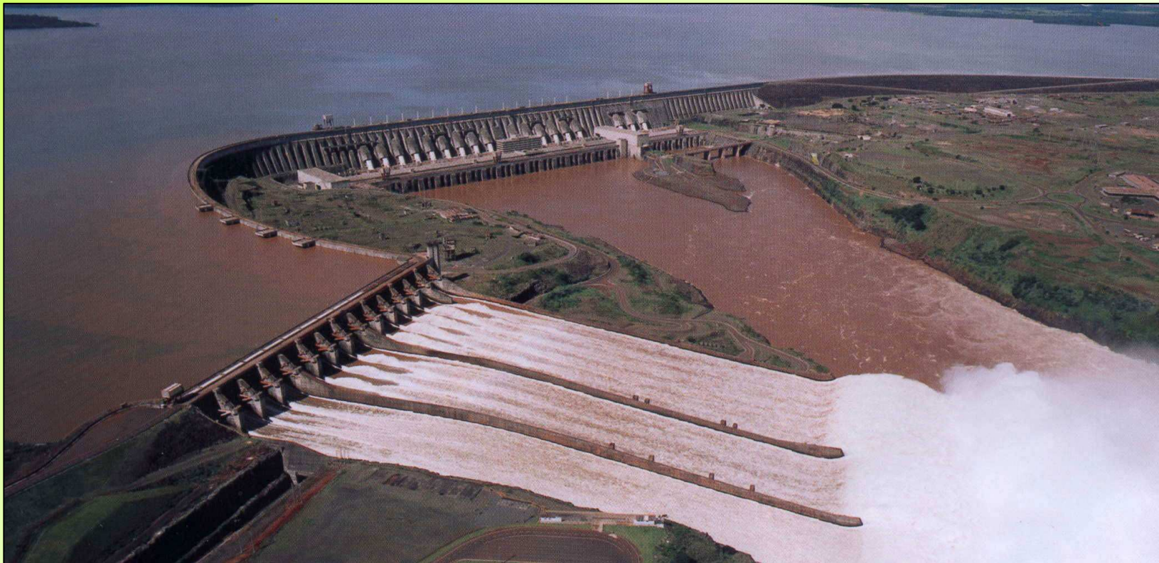
Hochwasserentlastungsanlage Itaipu, Brasilien/Paraguay
